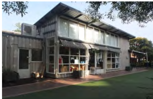
Robert Cochrane Kindergarten (VHR H2309)
